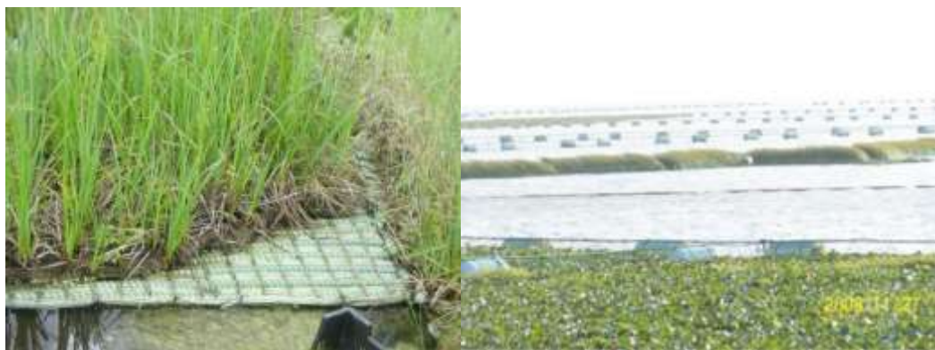
Slika. Tehnična konstrukcija RPO ter slika (desno) prikaz rastlinskih pasovnih filtrov v akumulaciji.
