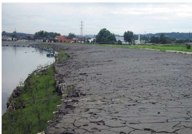
Slika: Pogled na brežino Ptujskega jezera, kamor je bil naložen mulj, po približno enem mesecu od konca del.
